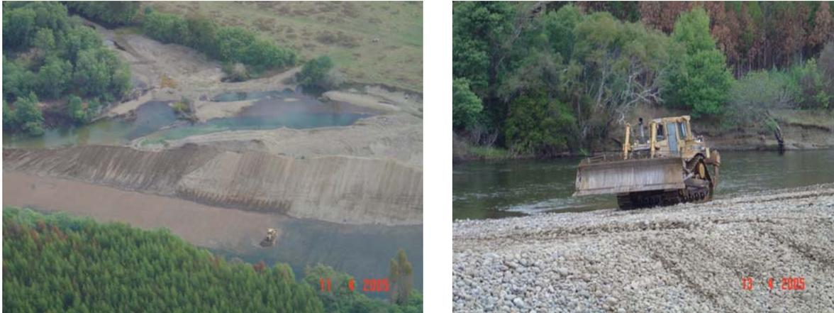
Fotografía 2. Movimiento de áridos en el cauce del río Cruces, aguas arriba de San José de la Mariquina. A la izquierda se observa la pluma de dispersión de color marrón que se desplaza por el río Cruces, producto de la actividad de excavación del buldózer sobre el fondo del río.
